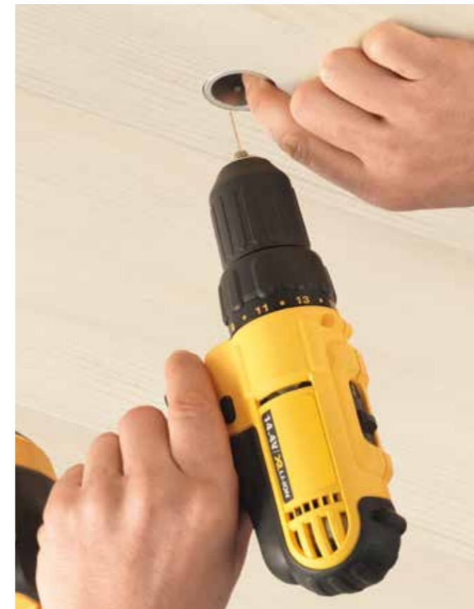
Montage HOLZEINBAURING 28.
